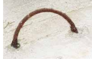
Lastverteilung durch Beton mit Transportösen
